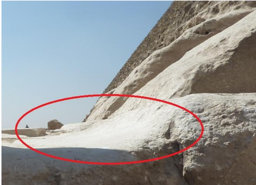
Fig. 4 erosione di tipo uniforme su una roccia in calcare
