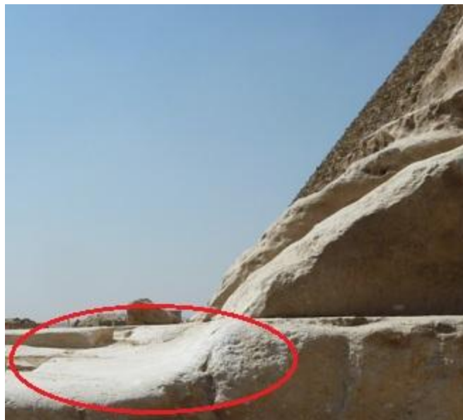
Fig. 15 Consumo della pavimentazione immediatamente al di fuori dei blocchi del rivestimento nel punto 6, evidenziata nell'ovale rosso
