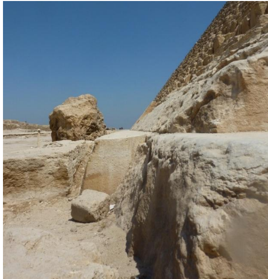
Fig. 21 Consumo o erosione della pavimentazione immediatamente al di fuori dei blocchi del rivestimento nel punto 10
