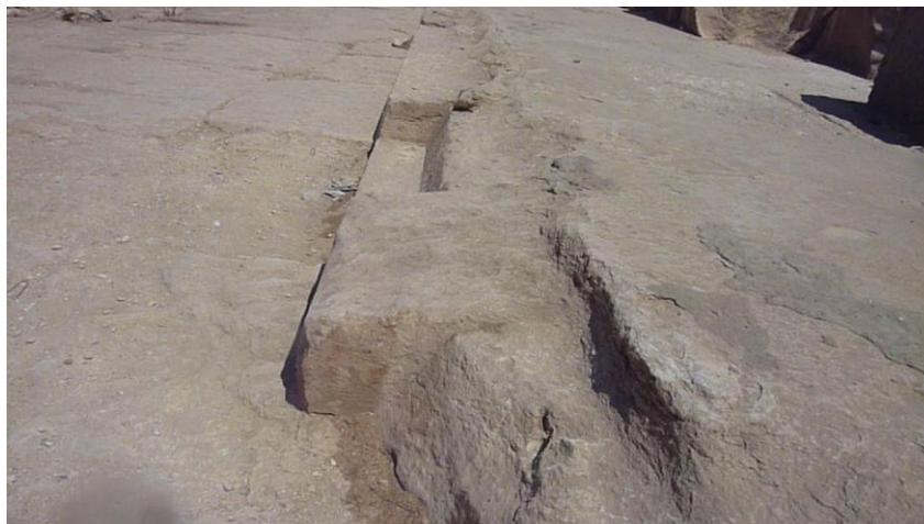
Fig. 20 Consumo o erosione della pavimentazione immediatamente al di fuori dei blocchi del rivestimento nel punto 9
