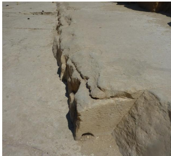
Fig. 22 Consumo o erosione della pavimentazione immediatamente al di fuori dei blocchi del rivestimento nel punto 11
