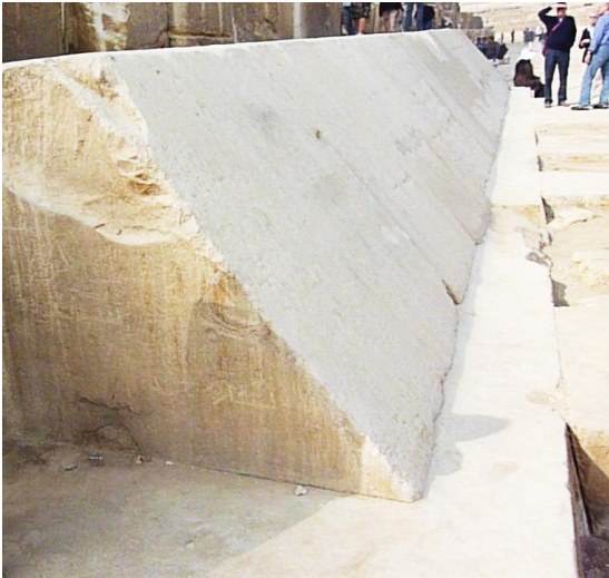
Fig. 8 e 9 Particolare della piramide di Khufu in corrispondenza del punto 1. A sinistra gli unici blocchi del rivestimento in calcare rimasti, e a destra la netta differenza di erosione fra la parte in basso (rimasta esposta fin dall'epoca della costruzione della piramide) e la parte in alto (esposta agli agenti erosivi da soli 675 anni)
