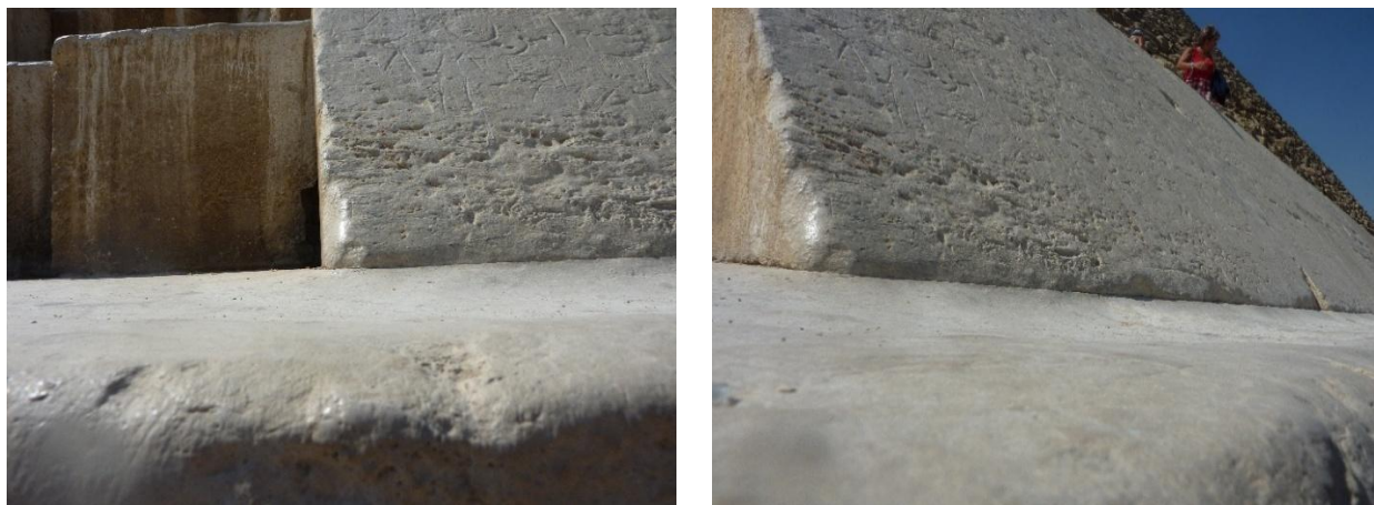
Fig. 12 e 13 Consumo della pavimentazione immediatamente al di fuori dei blocchi del rivestimento nel punto 3
