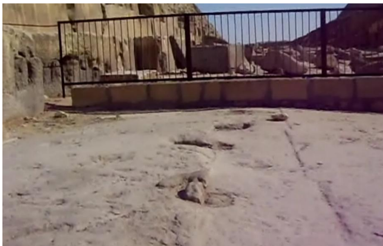
Fig. 43 Consumo o erosione della pavimentazione immediatamente al di fuori dei blocchi del rivestimento nel punto 25
