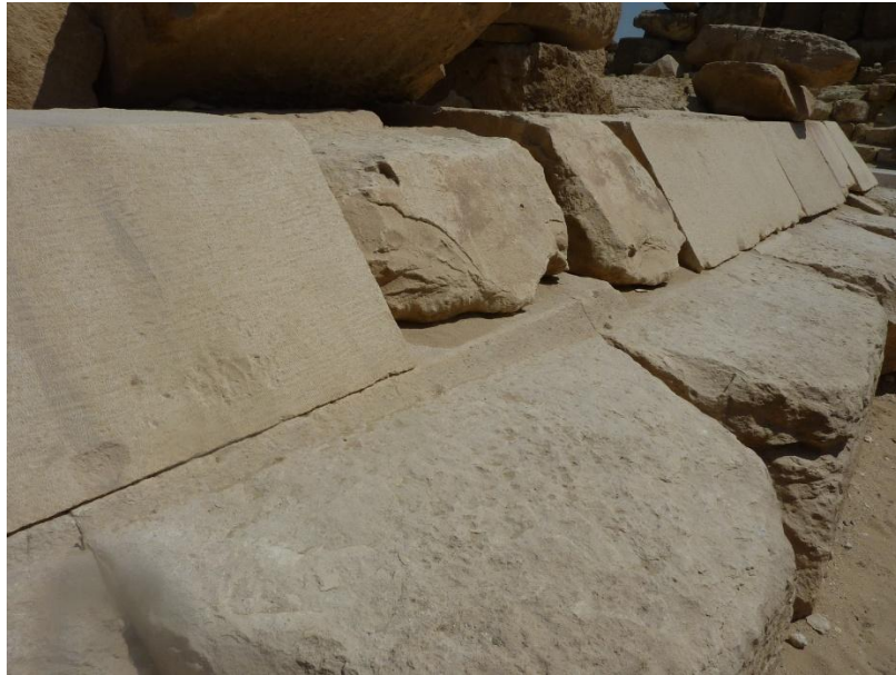
Fig. 31 Consumo o erosione della pavimentazione immediatamente al di fuori dei blocchi del rivestimento nel punto 16
