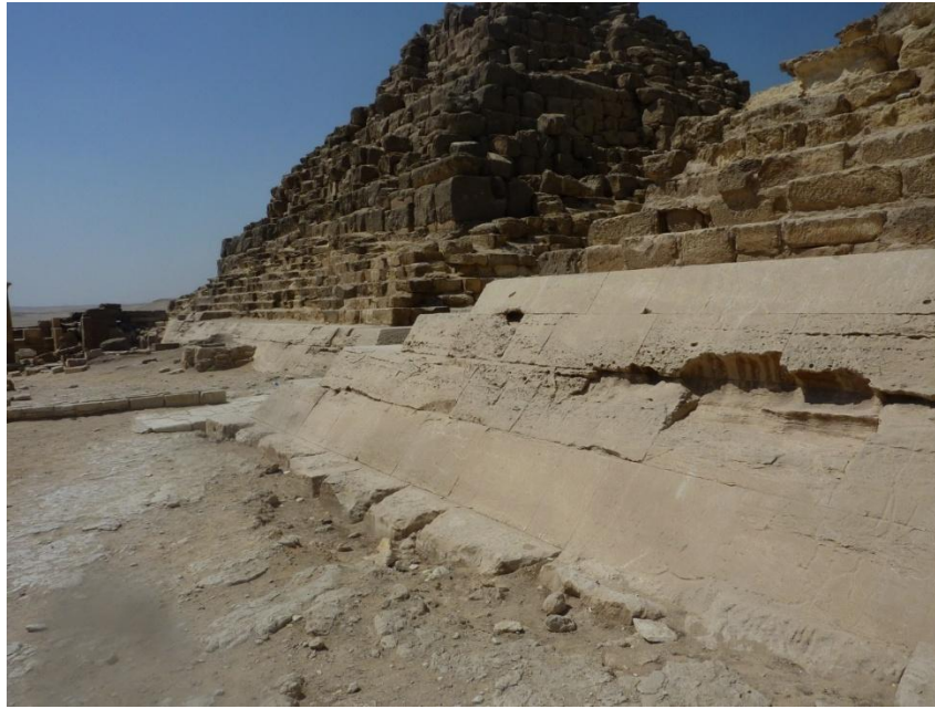
Fig. 28 Consumo o erosione della pavimentazione immediatamente al di fuori dei blocchi del rivestimento nel punto 14
