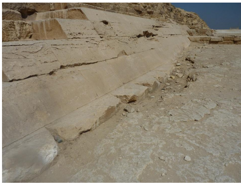
Fig. 27 Consumo o erosione della pavimentazione immediatamente al di fuori dei blocchi del rivestimento nel punto 13
