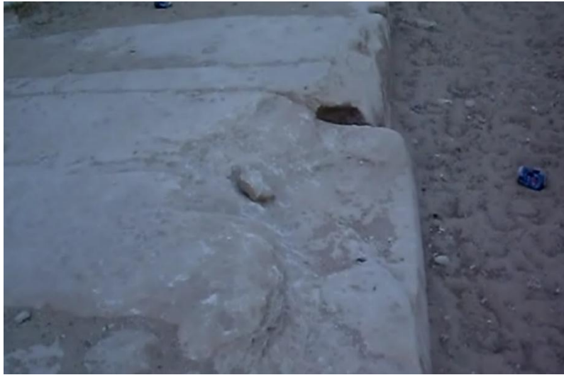
Fig. 36 Consumo o erosione della pavimentazione immediatamente al di fuori dei blocchi del rivestimento nel punto 20
