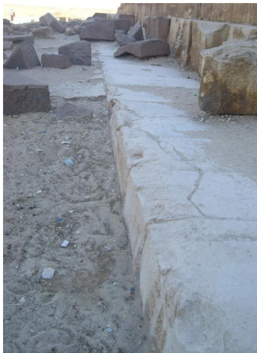
Fig. 35 Consumo o erosione della pavimentazione immediatamente al di fuori dei blocchi del rivestimento nel punto 19
