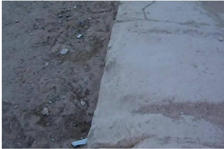
Fig. 38 Consumo o erosione della pavimentazione immediatamente al di fuori dei blocchi del rivestimento nel punto 22
