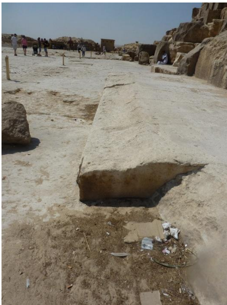
Fig. 17 e 18 Consumo o erosione della pavimentazione immediatamente al di fuori dei blocchi del rivestimento nel punto 7
