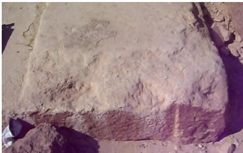
Fig. 33 Consumo o erosione della pavimentazione immediatamente al di fuori dei blocchi del rivestimento nel punto 17
