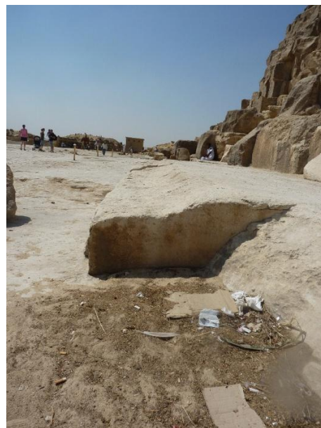
Fig. 17 e 18 Consumo o erosione della pavimentazione immediatamente al di fuori dei blocchi del rivestimento nel punto 7
