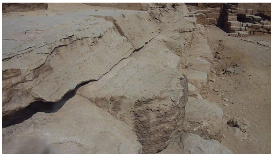
Fig. 30 Consumo o erosione della pavimentazione immediatamente al di fuori dei blocchi del rivestimento nel punto 15
