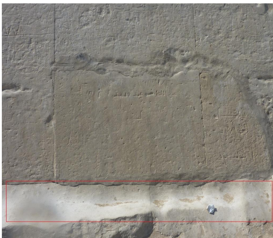
Fig. 14 Consumo della pavimentazione immediatamente al di fuori dei blocchi del rivestimento nel punto 3, evidenziata nel rettangolo rosso
