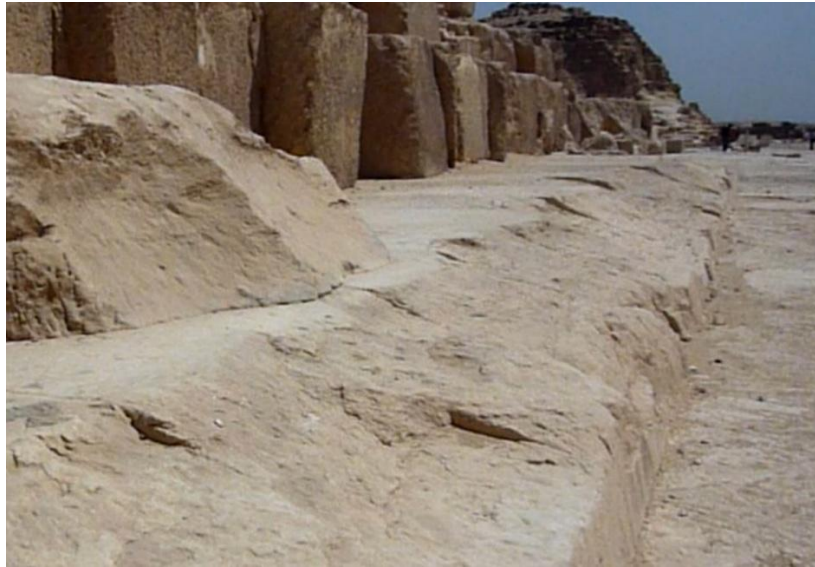
Fig. 19 Consumo o erosione della pavimentazione immediatamente al di fuori dei blocchi del rivestimento nel punto 8
